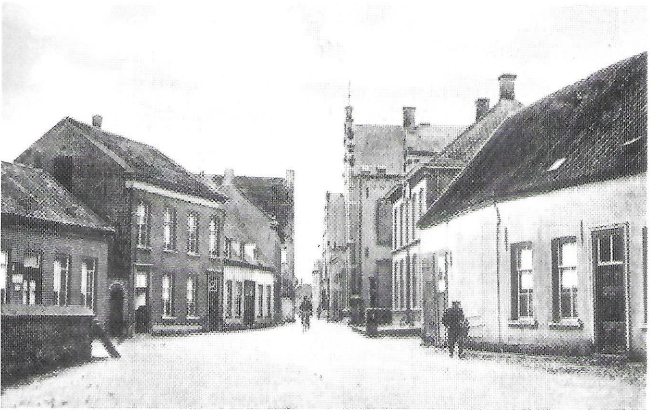
De 'harmoniezaal' (repetitielokaal) rond 1910: bovenverdieping van het hoge huis links in toen de Kerkstraat
